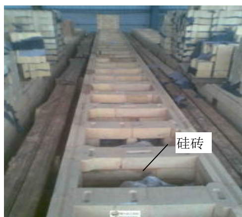
图1 采用高导热硅砖的焦炉炭化室
